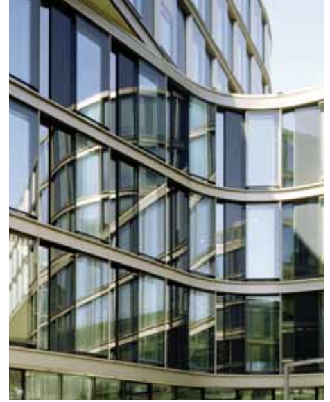
Fassadendetail, Foto © K. Frahm
