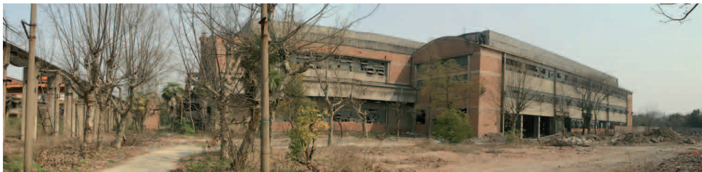
外部效果图及建筑现状
