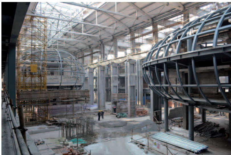
施工现场照片
