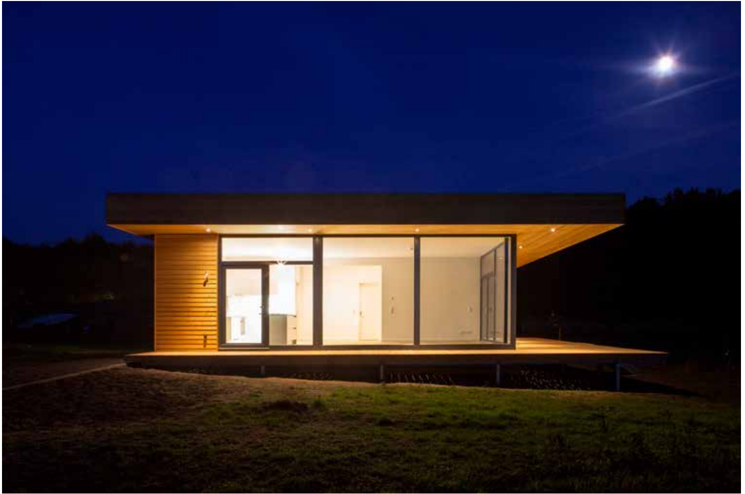
Westfassade mit Eingang und Terrasse (Foto © Li Yuanhao)
